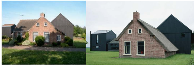
Oude en nieuwe situatie (architect Jelle de Jong)
