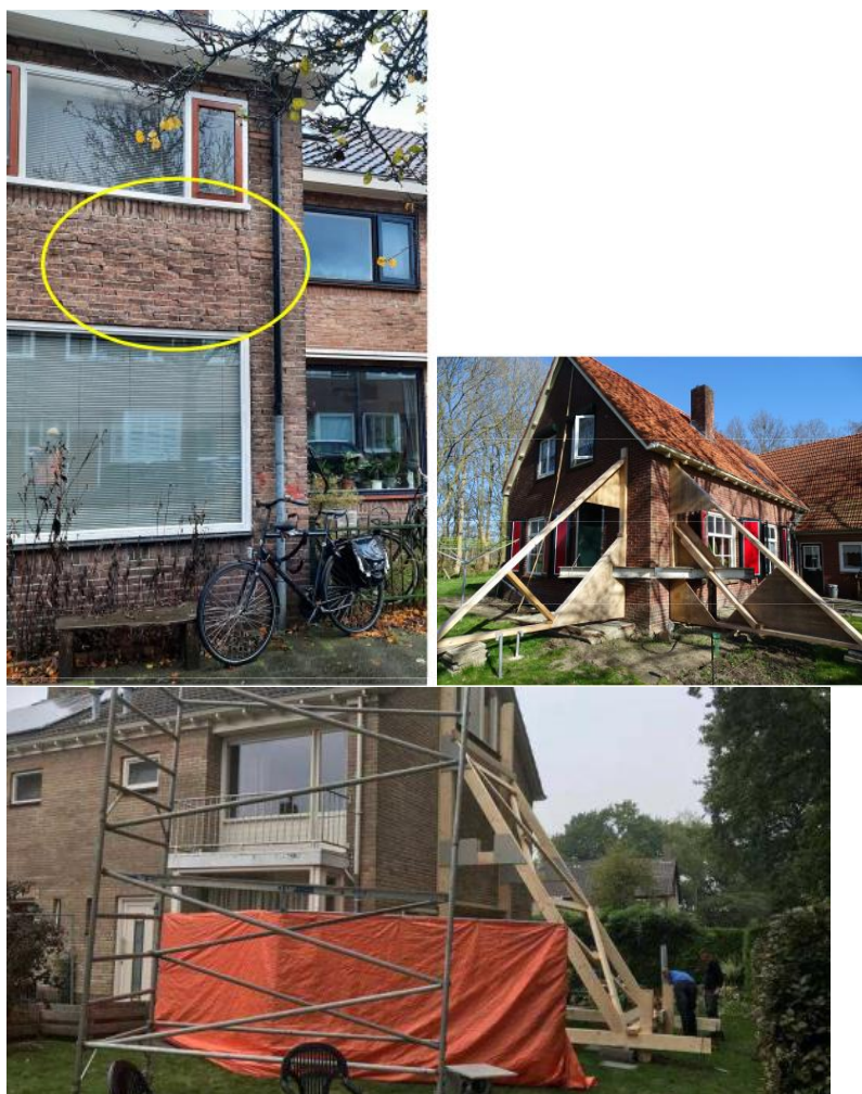
Figuur 8.6 Voorbeelden schade ten gevolge van krimp/zwel van klei (Utrecht, Zevenaar, Roden met klok mee).
