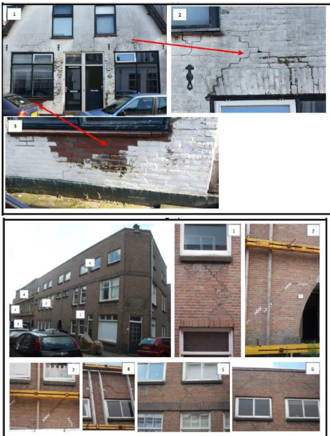
Figuur 5.1 Schadeklassen 2 t/m 5 (van boven naar beneden).
