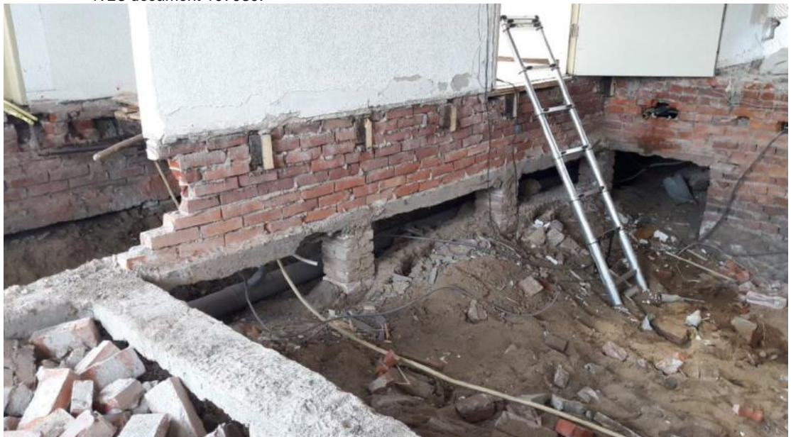
Figuur 4.3 Fundering op poeren van circa 2 m diep, al dan niet uitgetande voet [Deltares rapport kanaal Almelo].
