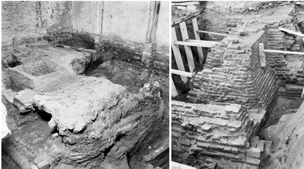
Figuur 4.2 Foto fundering op poeren rond 1620 in Den Bosch - Rijksdienst voor het Cultureel Erfgoed Documentnummer 135650 (links) en op staal in metselwerk Hasselt Overijssel waarschijnlijk uit 1725 document 107930.
